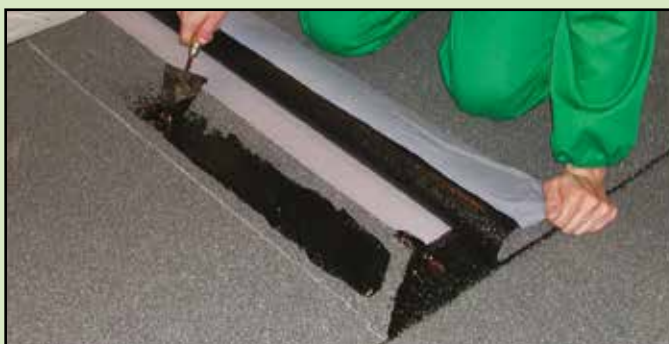
7. Saldare le sovrapposizioni di testa con HEADCOLL
