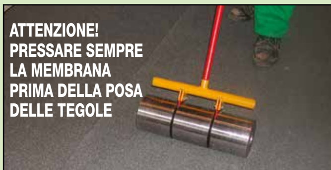
8. Pressatura generale prima della posa delle tegole
