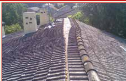
7. Saldare le sovrapposizioni di testa con HEADCOLL
